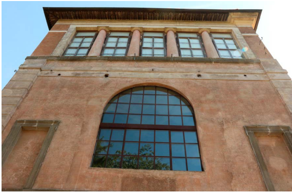
5. Villa Poniatowski, fragment elewacji
